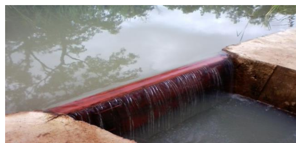
Photo 1 : Digue submersible de Filamana, 2013. Source Samaké 2013
