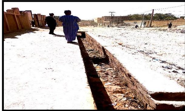
Ces caniveaux dans ce quartier, ont été réalisés pour faciliter le drainage des eaux de pluie afin d'éviter les inondations dans sa zone de réalisation.
