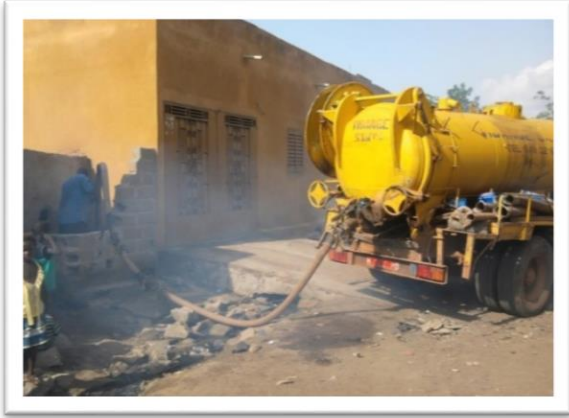
Photo 1 : vidange motorisée d'une fosse à Sotuba ACI Photo 2 : vidange manuelle d'une fosse à Banconi Source : clichés personnels, I. Ouattara, 2022
