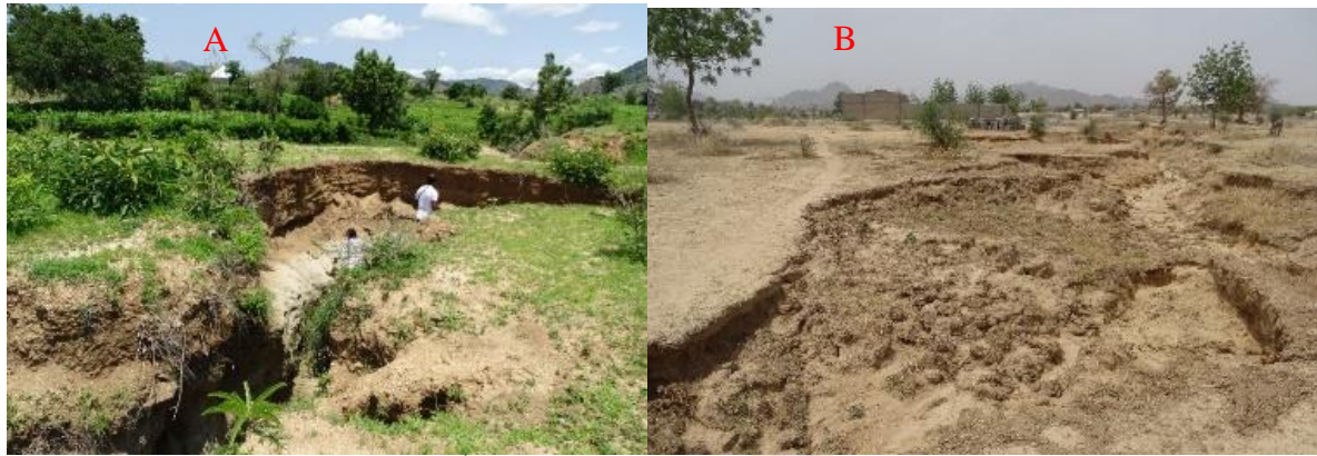
Planche des photos 1. Érosions hydriques (A : 10°34' 36" N, 13°59' 30" E ; B : 10°34' 45" N, 14°02' 05" E) sur des parcelles litigieuses à Mowo
