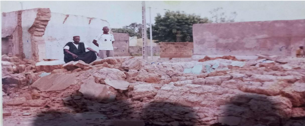
Photo 12 : maison effondrée dans le quartier Filawèrè (2007)
