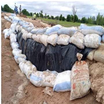
Photo 7 : construction de digues sur les berges du Wolon
