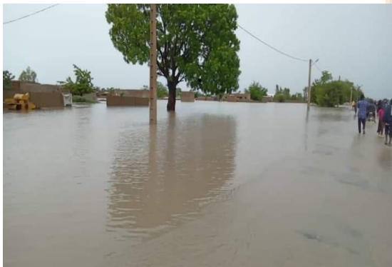
Photo 10 : La RN12 submergée d'eau
