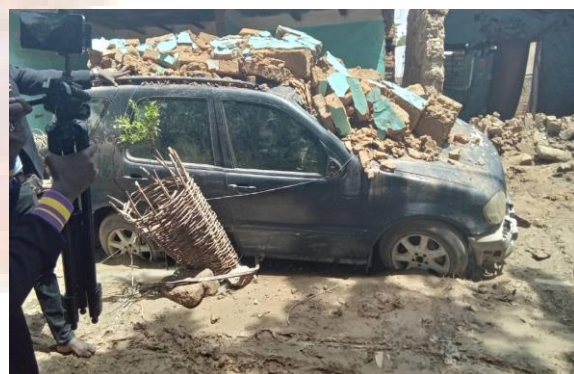
Photo 11 : Maison effondrée à Bla Koko
