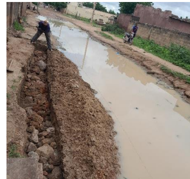
Photo 9 : travaux de renforcement des fondations de maisons à Bla Flawèrè
