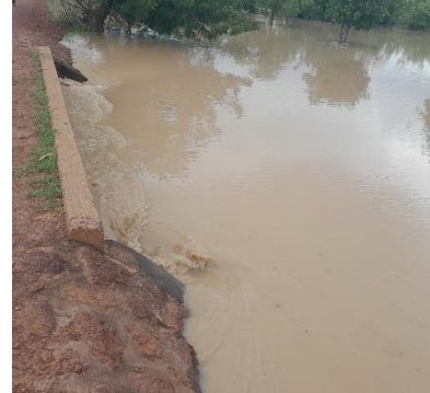
Photo 6 : Pont près du poste de contrôle (PK) sur la RN6
